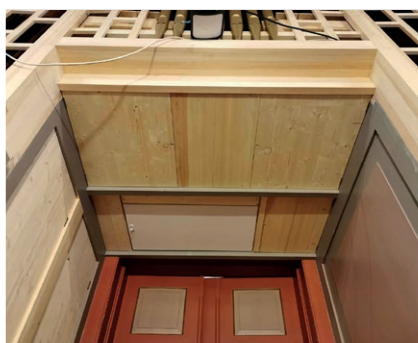
Nye takluker til hovedverk over inngangsparti
