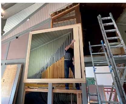
Installere svellramme og svellstue
